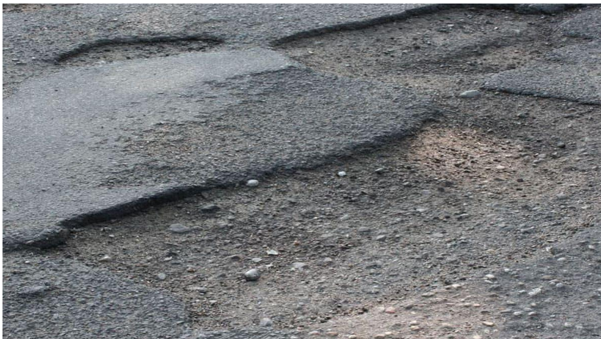
Figure 6 Bitume dégradé
