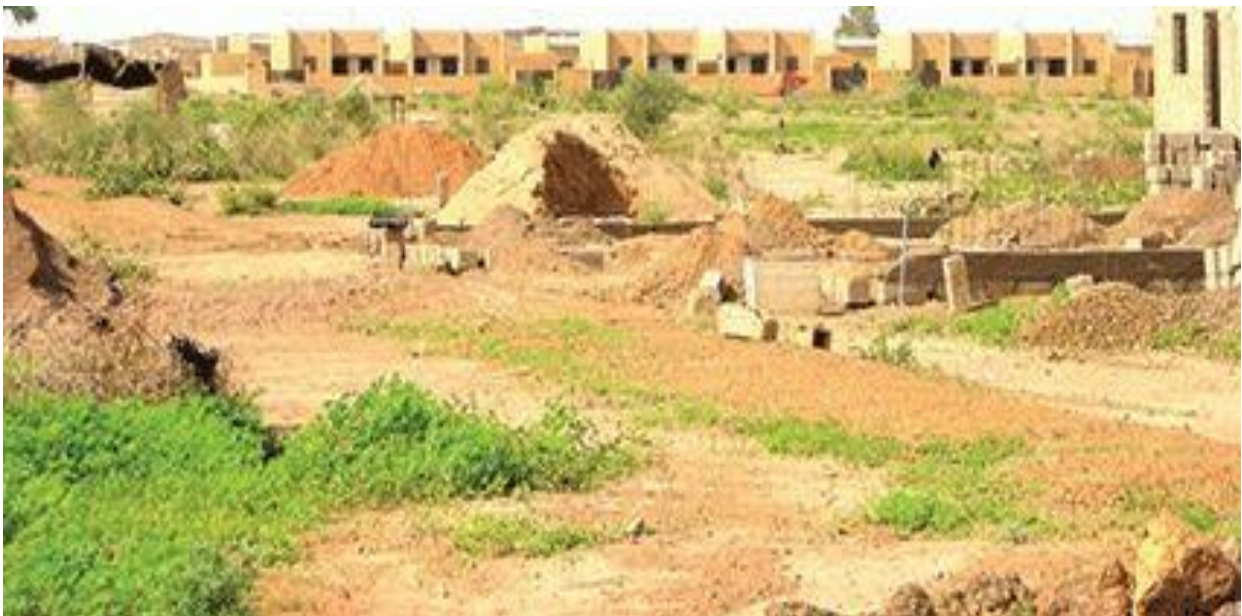
Photo 4: Une vue d'un chantier présentant des aspects pouvant nuire à l'environnement
