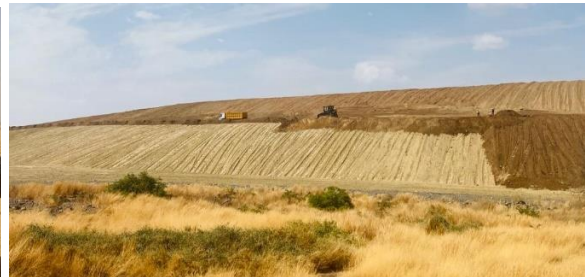
Photo 3: vue du revêtement avec la terre oxydée et le top soil
