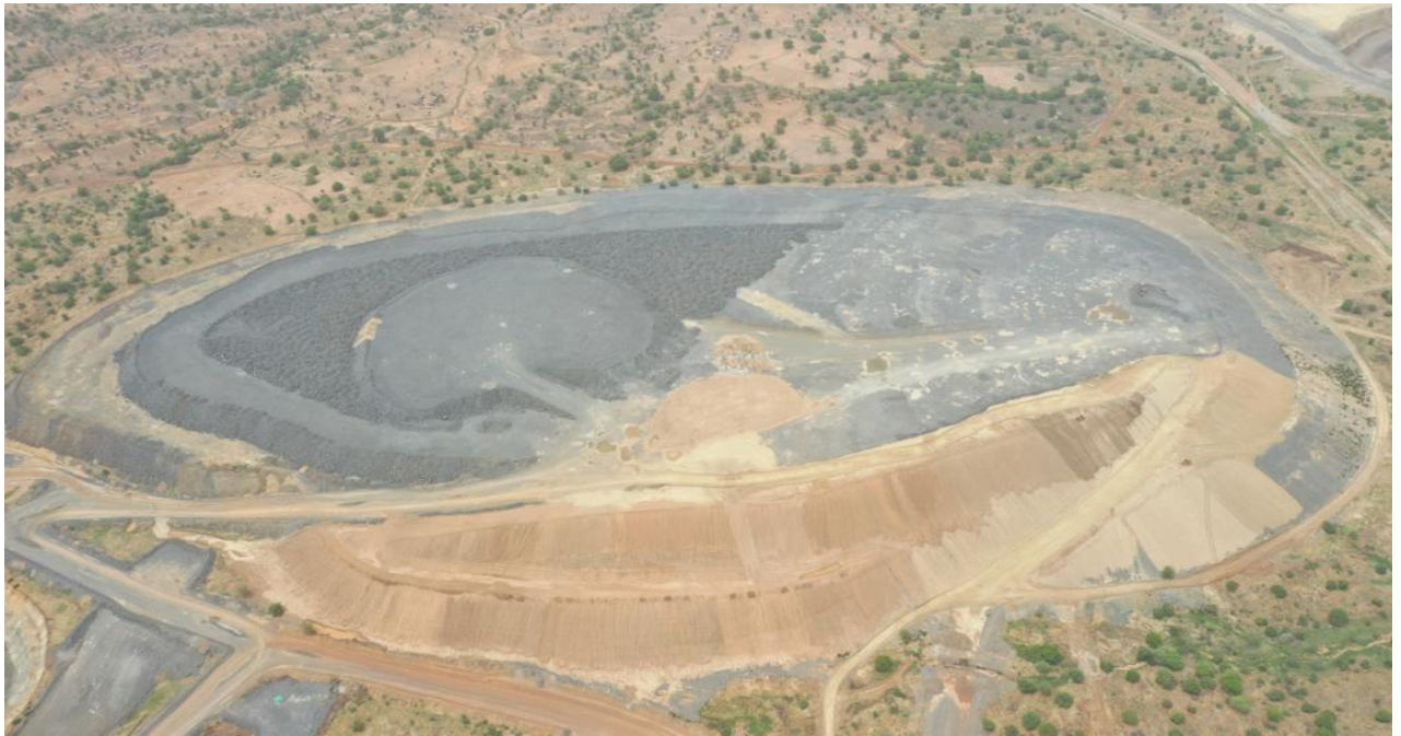
Annexe 10: Vu du waste dump à la fin des travaux de réhabilitation physique
