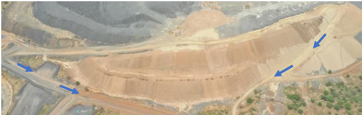
Photo 5: Réalisation de rampes
