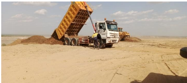
Photo 2: Travaux de re-couverture avec du top soil
