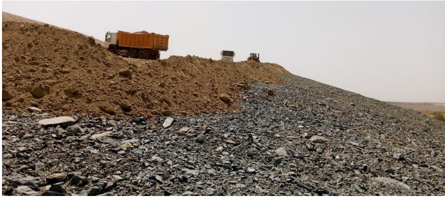
Photo 1: Travaux de revêtement avec de la terre oxydée
