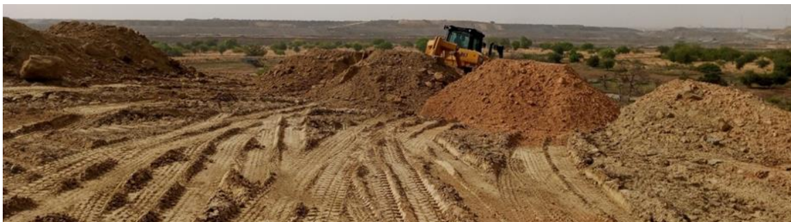
Photo 4: Travaux de réalisation de merlons
