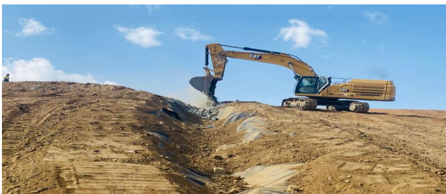
Photo 8: entreposage des roches sur les liners enfouis
