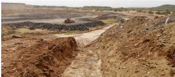
Photo 6: Réalisation de canaux de drainage
