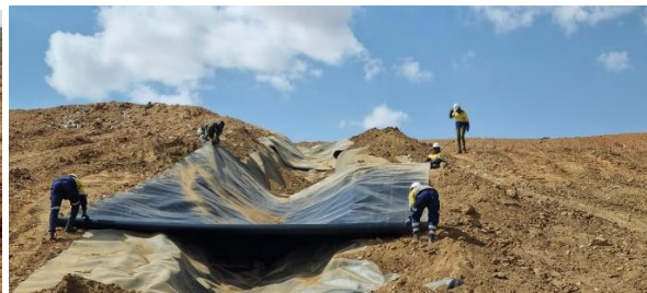
Photo 7: Enfouissement et stabilisation des liners à l'intérieur
