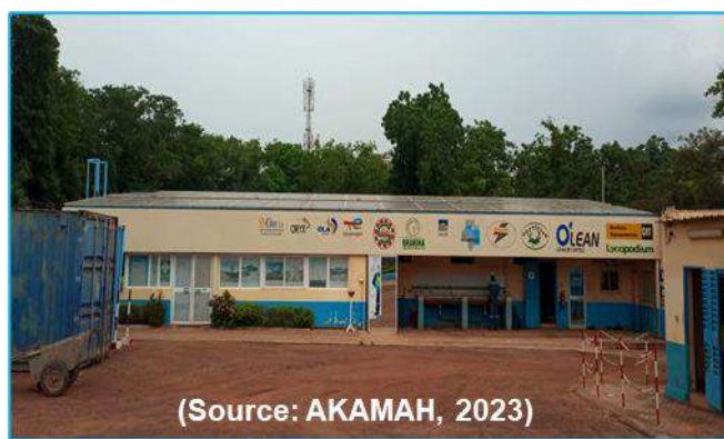
Figure 11: Centrale solaire de EERI BF
